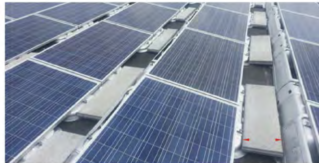
Beschwerungsfläche: 27cm bei 18° Verschattungswinkel 34cm bei 16° Verschattungswinkel (Schräglage des Steins möglich)
